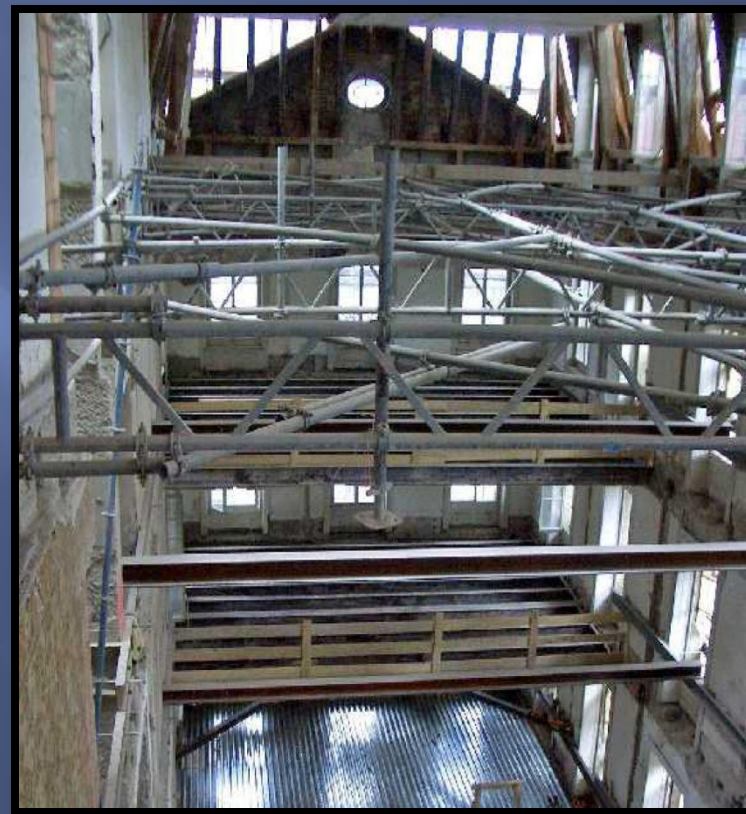
جایگزینی کف های بتن مسلح با کف های تیر چوبی در باله شرقی ساختمان
