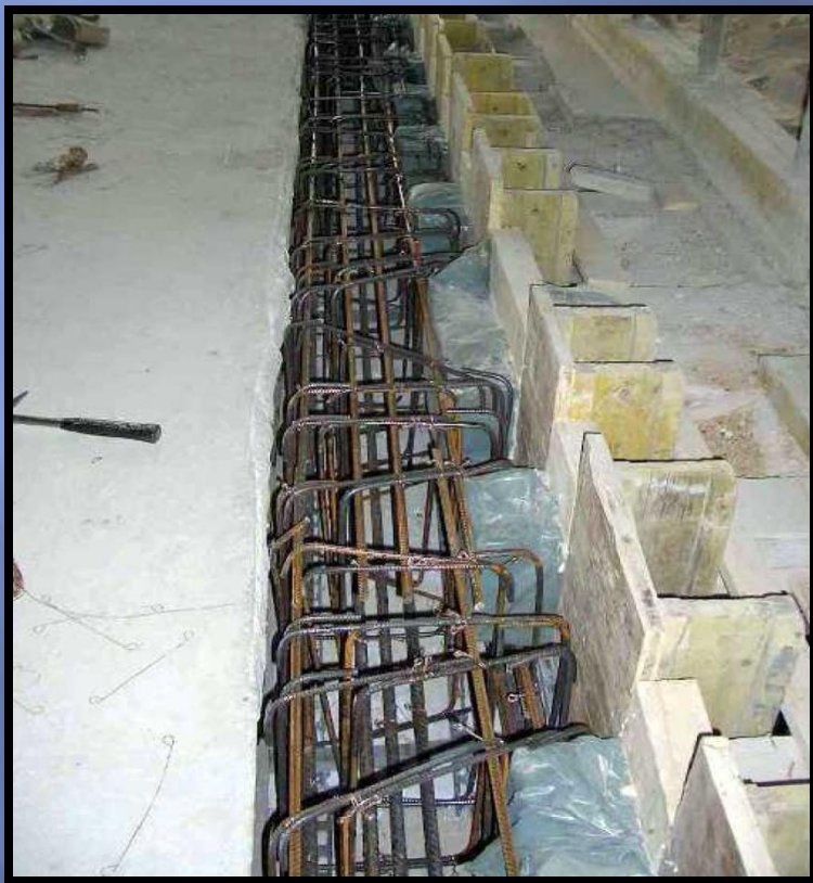
مهار آرماتورهای کف جدید در دیوار های بنایی
