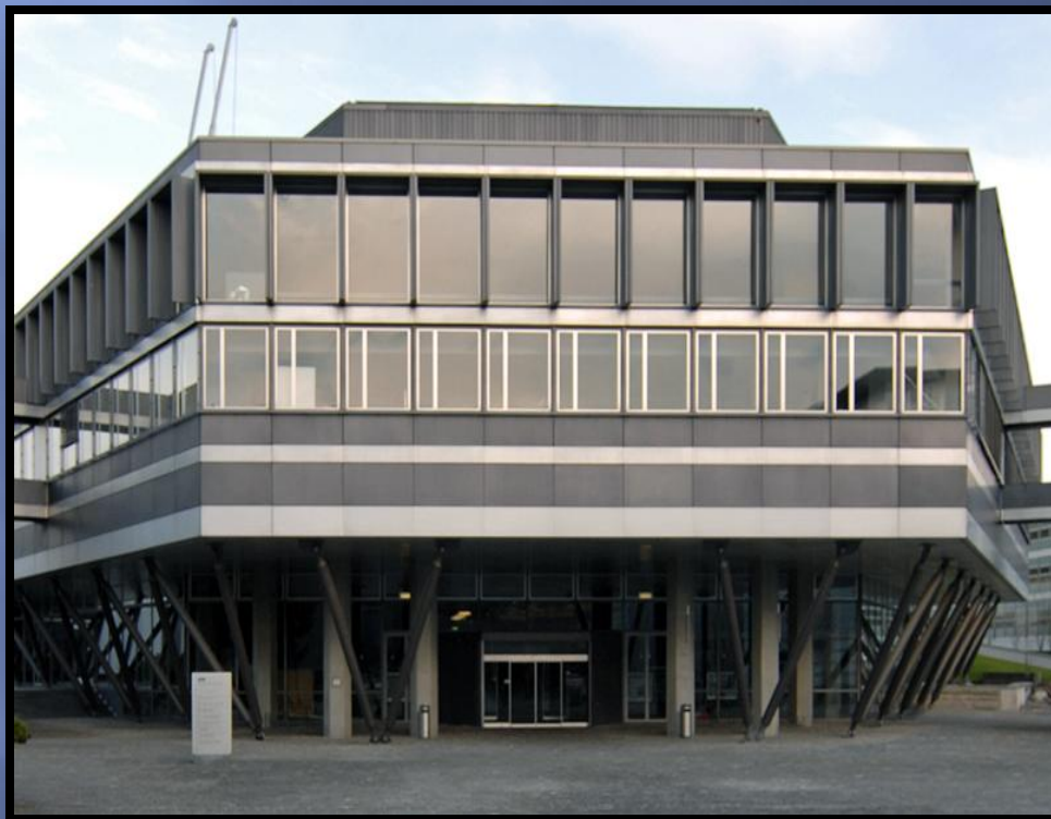
ساختمان با بادبندی نامتقارن (سالن درس در ETH زوریخ)
