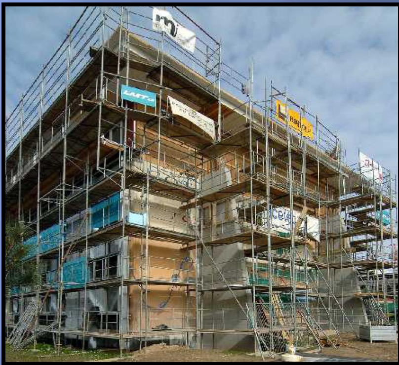
عملیات جدید ( ۲ پشت بند بتن مسلح مثلثی در نمای جنوبی)
