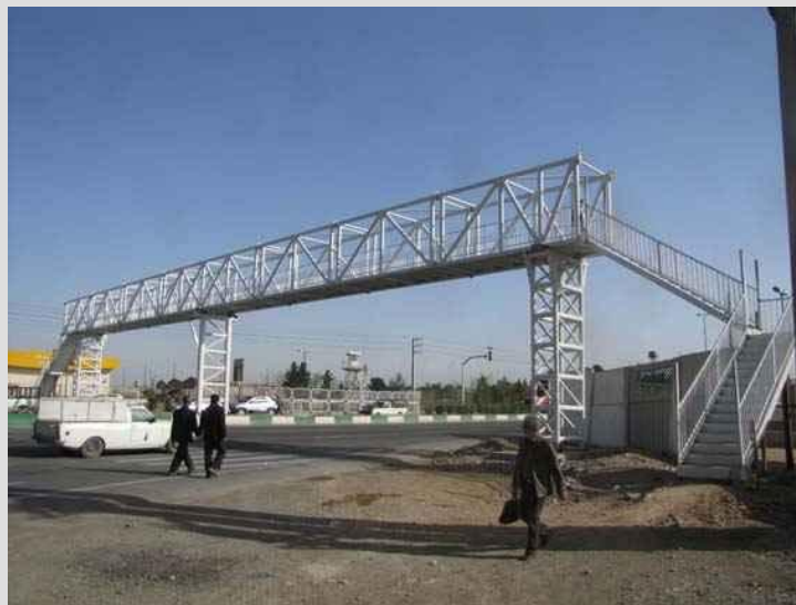
یک نمونه پل روگذر از نوع فلزی
