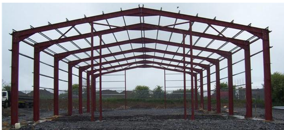
یک نمونه قاب شیبدار اروپایی از مقاطع نورد شده با اتصالات ماهیچه ای
