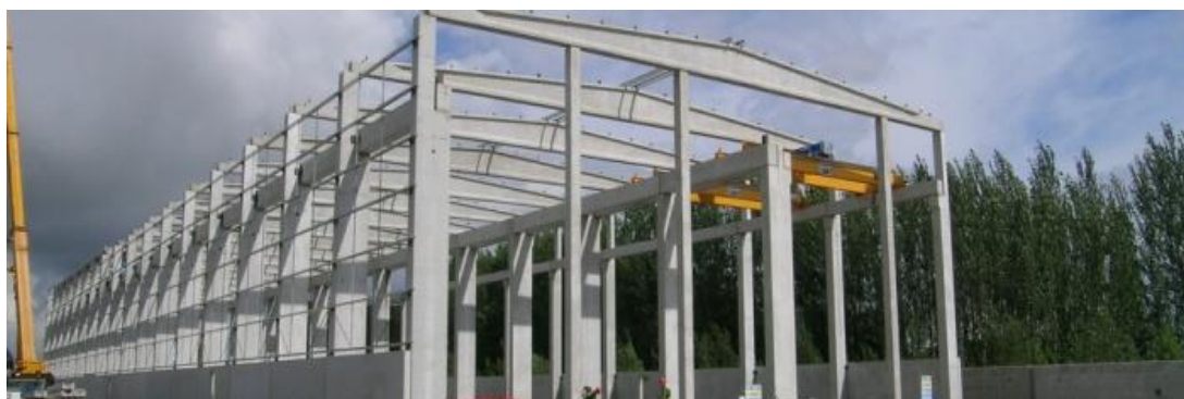
قاب شیبدار ساخته شده از مقاطع بتنی پیش ساخته
