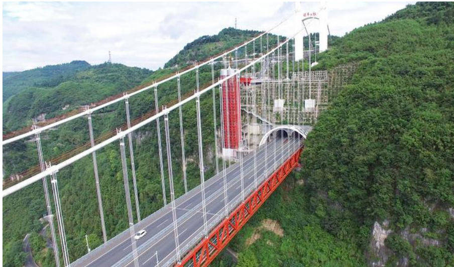
نمایی از پل پس از خروج از تونل (مرجع عکس: Highest Bridges )
