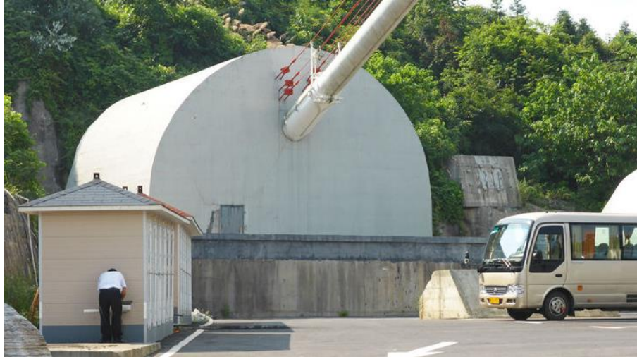
یکی از بزرگترین تکیه‌گاه‌های بتنی پل برای نگهداری کابل‌های کششی (مرجع عکس: Highest Bridges )
