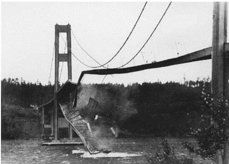
پل تاکوما ناروز پس از فرو ریزی
