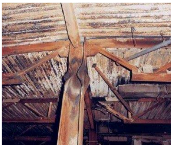
رخداد کمانش در ستون‌های فولادی
