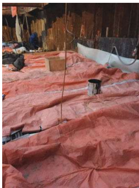
پوششی برای محافظت از میلگرد قبل از بتن‌ریزی در هوای سرد
