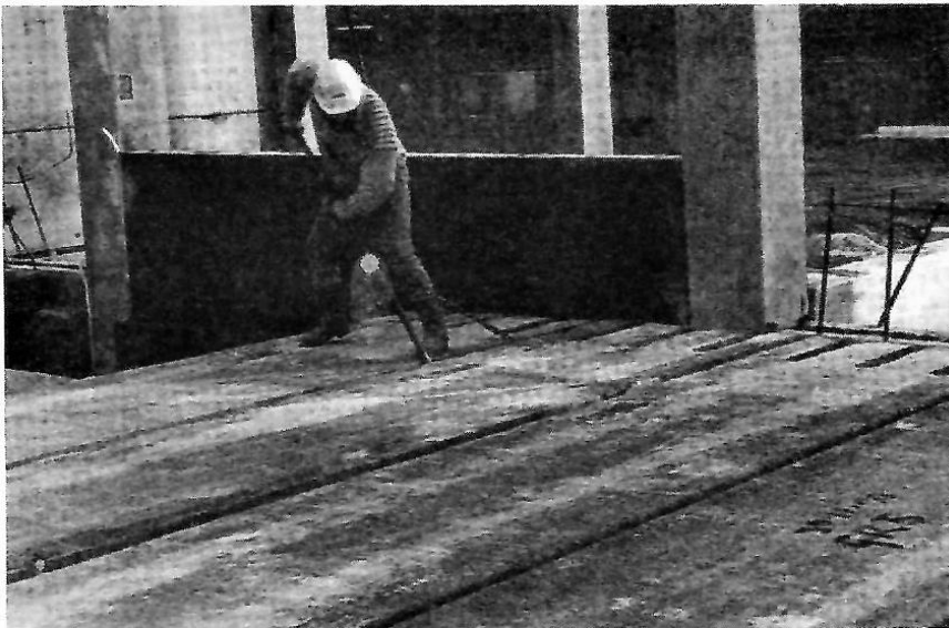
شکل ۴-۱۰ جابه جاکردن قطعات سقف به محل اصلی خودشان با استفاده از اهرم
