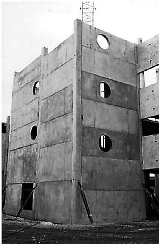
ساختمان پیش ساخته بتنی با سیستم دیوار باربر بتنی
