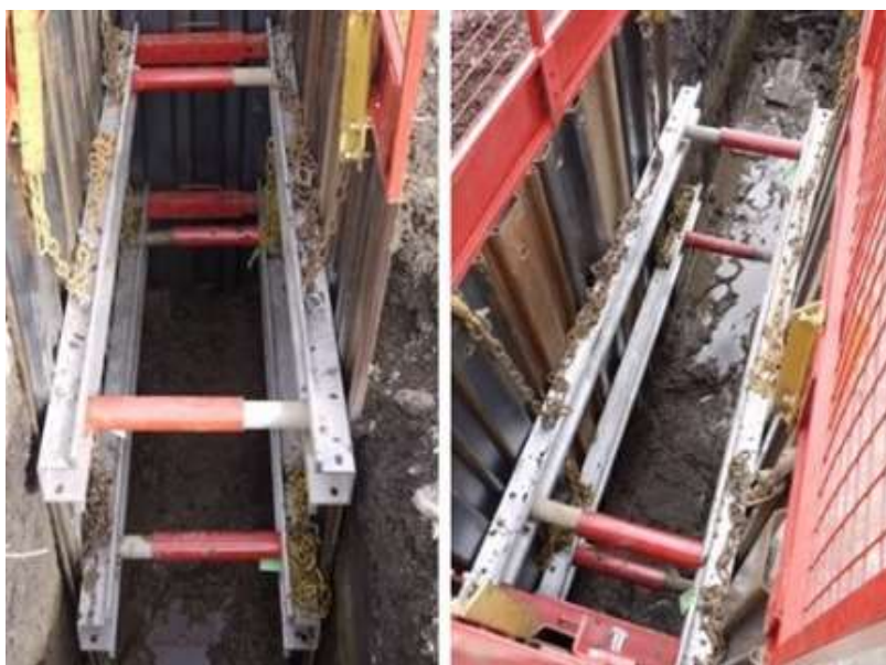
شکل ۳) سازه نگهدارنده حفاری قاب دیوار ساز هیدرولیکی قابل حمل
