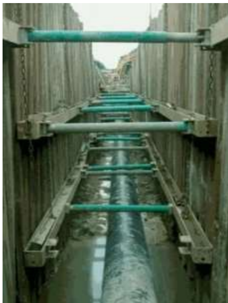
شکل (۲) سازه نگهبان قابل حمل مخصوص ترانشه
