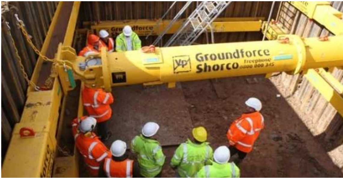
شکل (۱) سازه‌های نگهبان قابل حمل برای ترانشه و فونداسیون (مورد استفاده برای حفاری‌های سنگین)
