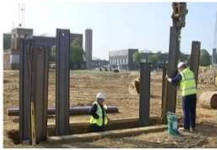
شکل ۴) فروکردن ورق‌ها در زمین
