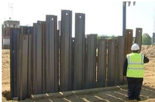
شکل ۶) نصب مابقی ورق‌های فولادی ترانشه
