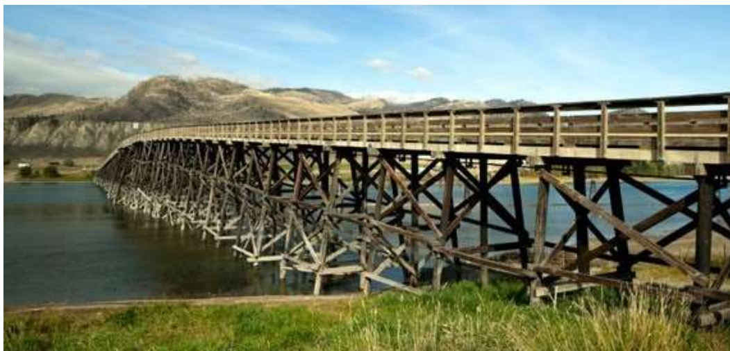
شکل ۳. شمع‌های چوبی استفاده شده در ساخت پل
