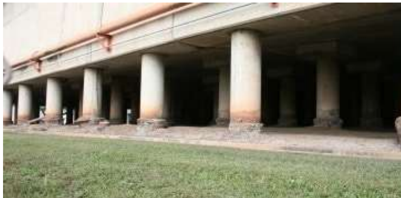
شکل ۱. حمله سولفات به پی های بتنی
