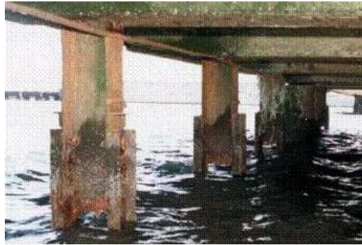
شکل ۶. خوردگی شمع فولادی در شرایط دریایی
