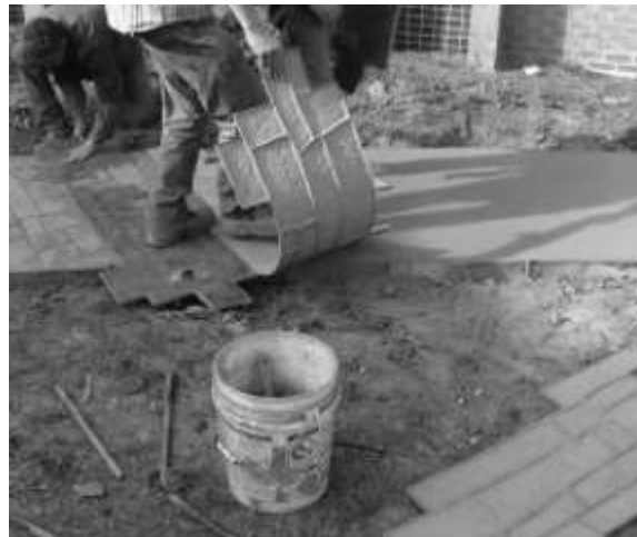
شکل ۱. آماده‌سازی بتن استامپی در یک راه بتنی
