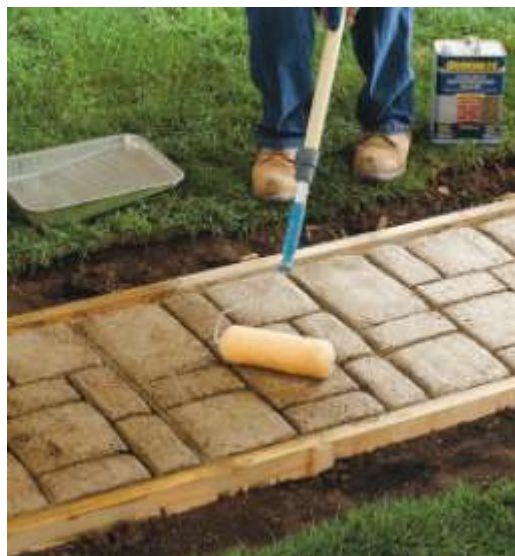
شکل ۷. پرداخت بتن استامپ با استفاده از سیلر بتن
