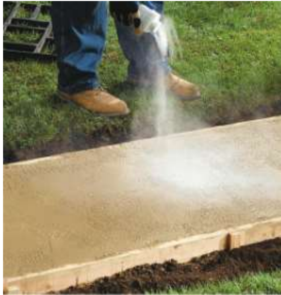
شکل ۴. آماده‌سازی سطح بتن برای استامپ
