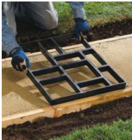
شکل ۵. اولین استامپ بر روی سطح بتن
