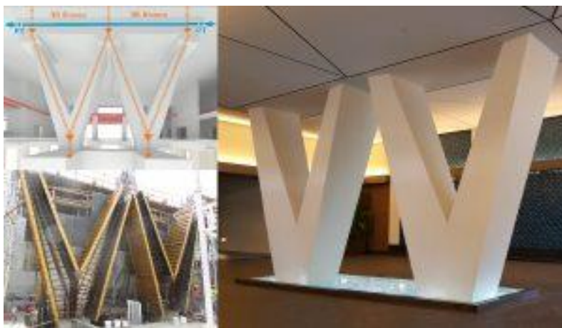
از بالا سمت چپ: انتقال بار از طریق ستون W؛ ستون W در حال ساخت؛ و ستون W تکمیل شده
