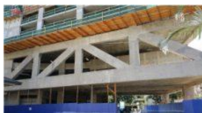
نقشه خرپای بتنی پس کشیده (بالا) و خرپای تکمیل شده (پایین).
