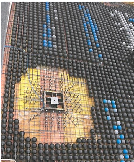
شکل ۶. قالب‌های توخالی در محدوده ستون‌ها حذف شده‌اند
