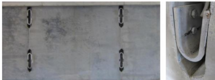
ورقه‌های خمشی U شکل مابین دیوارهای برشی در یک سازه بتنی صلیبی در منطقه جنوبی کرایستچرچ.
