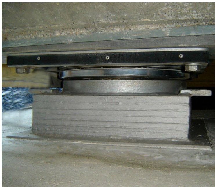
لرزه گیر در پلها
