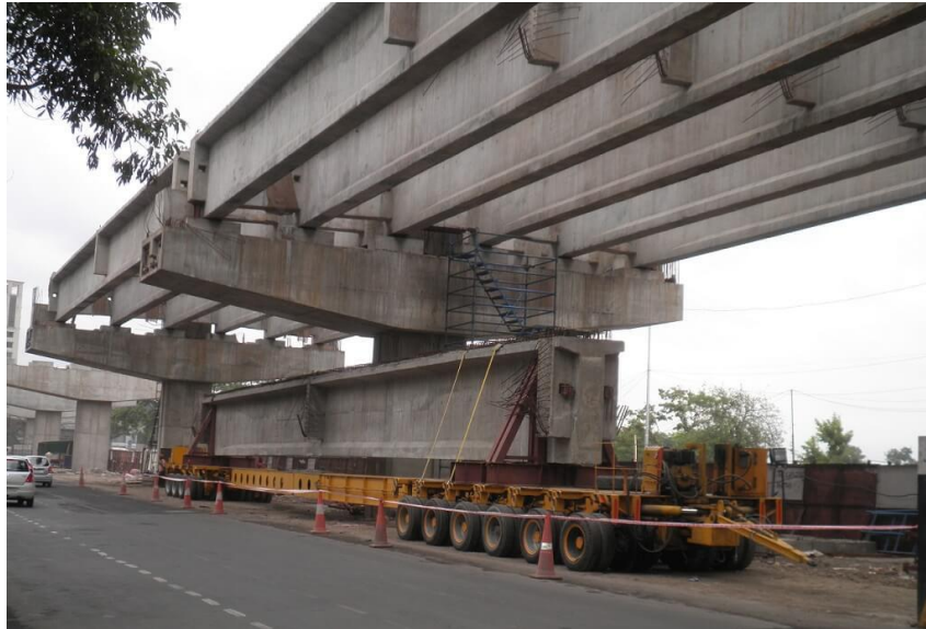
تیر اصلی پیش تنیده در پل
