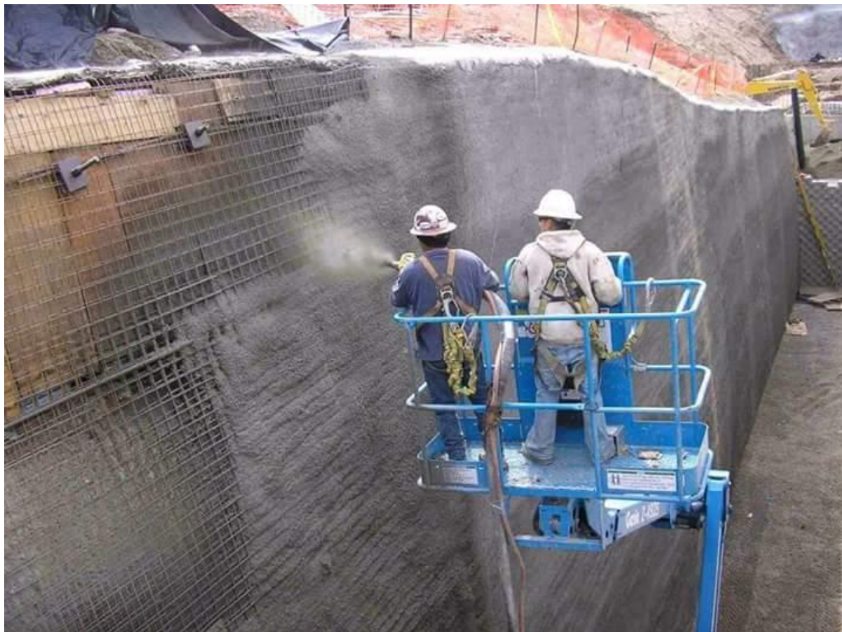
کاربرد بتن پاشیده در پایداری خاکریز شیب‌دار
