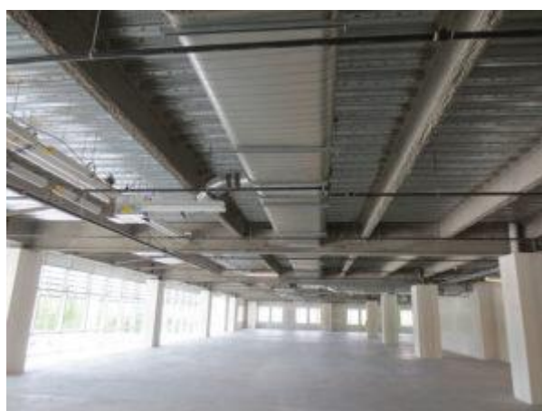
شکل ۳. بازشدگی جان شاه تیر فولادی
