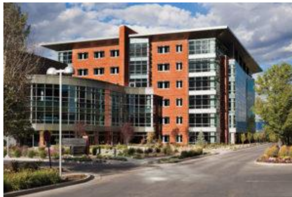
شکل ۱. مجموعه ساختمان اداری
