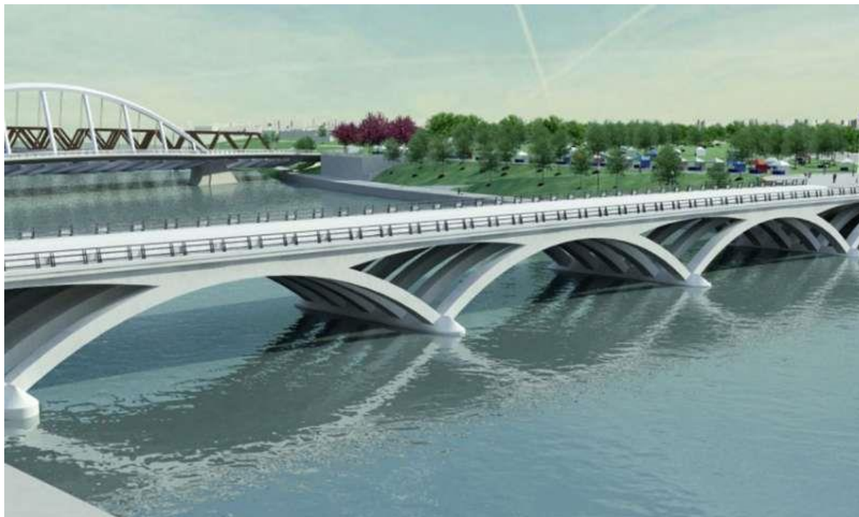
پل نشان دهنده قوس بهینه. از: پرفسور واندا لوئیس
