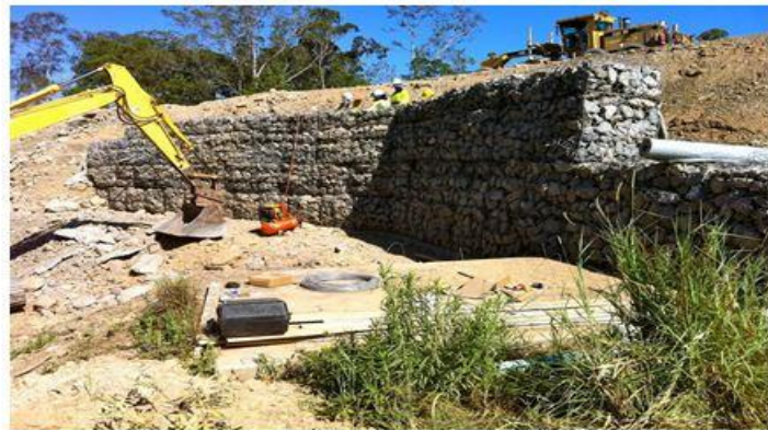
شکل ۳ دیوار گابیونی در حال ساخت
