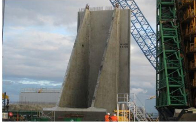
شکل ۶ دیوارهای طره ای پشت بنددار
