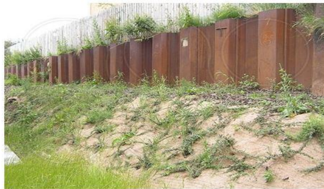
شکل ۷ دیوار حایل سپری
