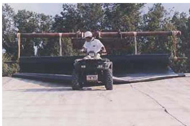
شکل 13: قرار دادن ژئوممبرین روی GCL توسط ATV
