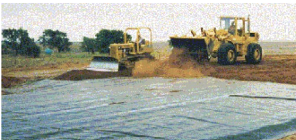
[شکل 22: قرار دادن خاک پوشش روی GCL]
