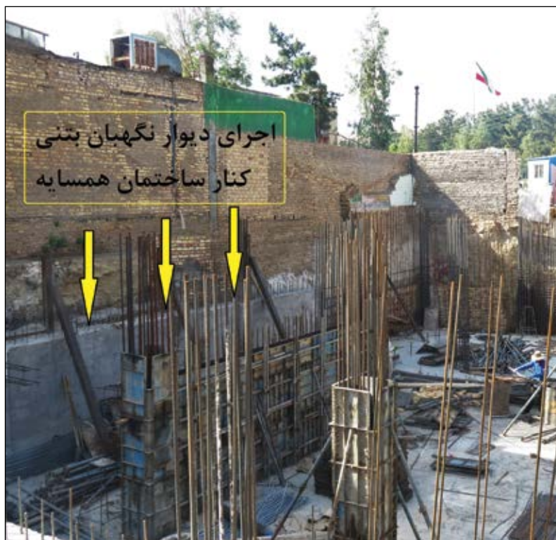
شکل ۷- مواجه شدن با یک لایه‌ی ماسه‌ی سست پس از آغاز عملیات گودبرداری، کارفرمای پروژه را بر آن داشته که به منظور جلوگیری از ریزش ساختمان همسایه، یک دیوار نگهدارنده بتنی اجرا نماید.
