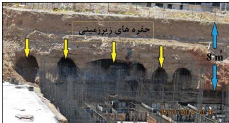
شکل ۴- حفره‌های موجود که از کوره‌های آجرپزی قدیمی به جای مانده‌اند، در عمق ۷ تا ۸ متری سطح زمین آشکار شده‌اند.
