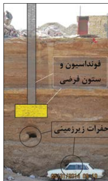
شکل ۵ و ۶- برخورد به حفره‌های زیرزمینی در حین گودبرداری
