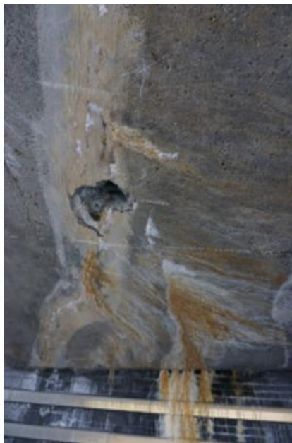
شوره‌زدگی و نفوذ آب بر روی طاق‌نمای جنوبی طره قابل مشاهده است.
