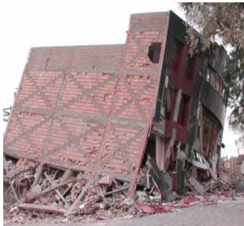
گسیختگی بادبندها و ایجاد طبقه نرم
