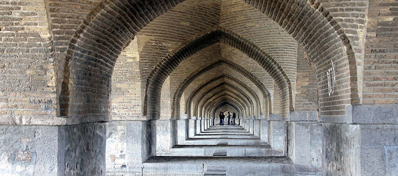
نمای داخلی پل خواجو
