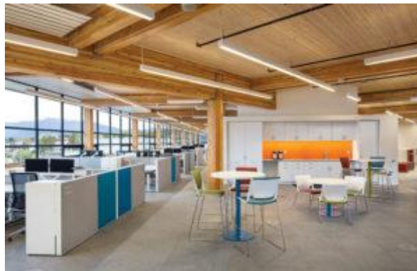
شکل ۲. پروژه انجام شده با پانل‌های NLT
