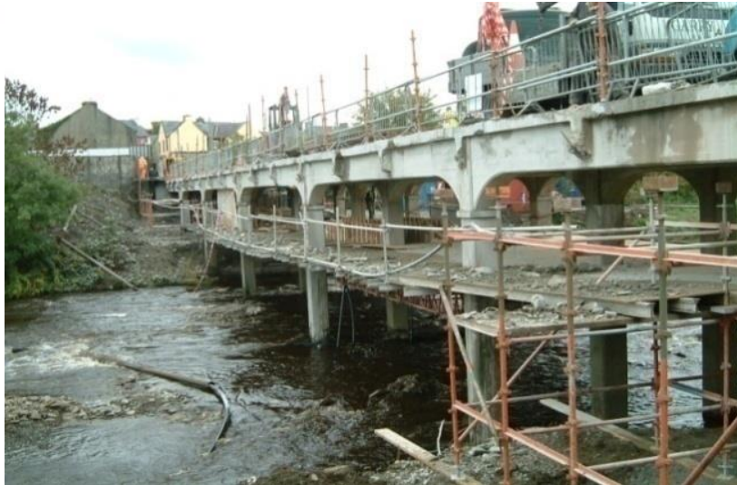
پروژه عریض سازی پل
