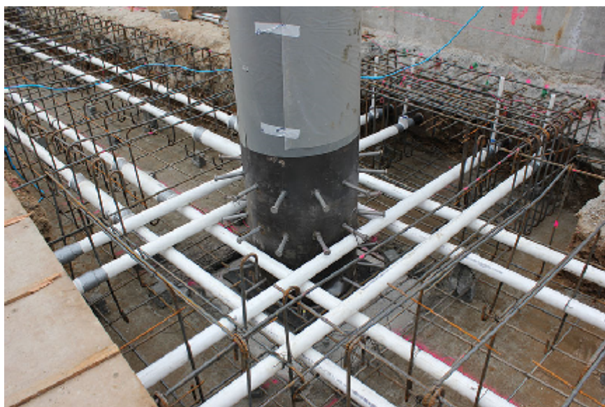
درگیری ستون در محل تقاطع با تیر. لوله‌های PVC آرماتورهای مقاومت بالای پیش تنیده را نگه می‌دارند.
