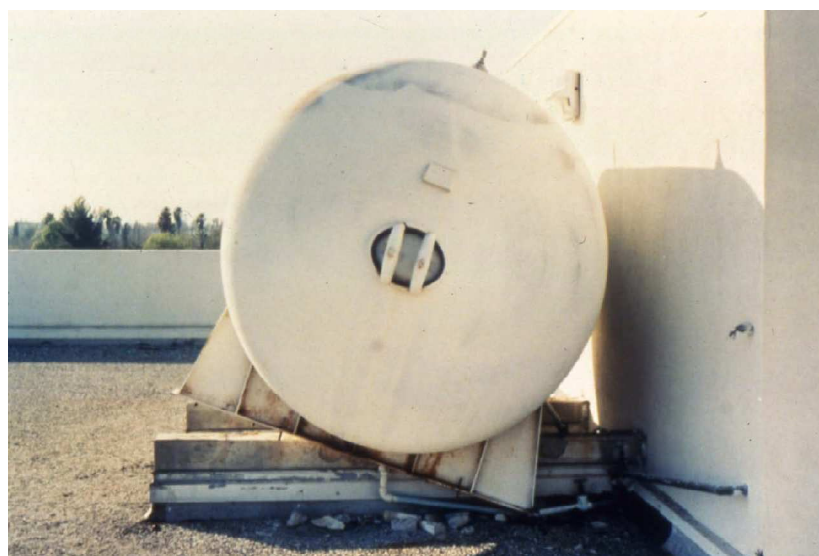
شکل (ت-۴-۴۴): آسیب‌های بوجود آمده بر تانکرها در اثر زلزله سال ۱۹۹۴ نوثریج (FEMA E-74, 2011)
