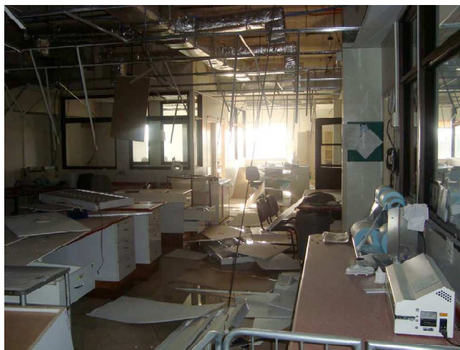
شکل (ت-۴-۲۶): نمایی از بهم ریختگی وسایل درون ساختمان در اثر زلزله سال ۲۰۱۰ شیلی (FEMA E-74, 2011)
