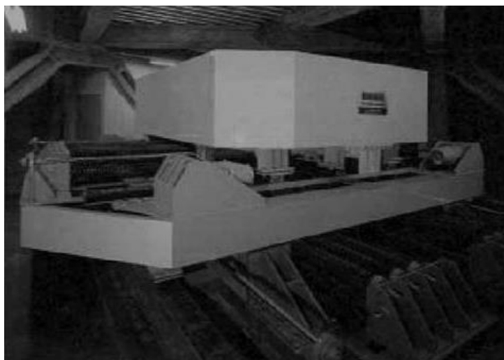
شکل ۵: میراگر جرمی تنظیم شده برای برج Chiha-Port
