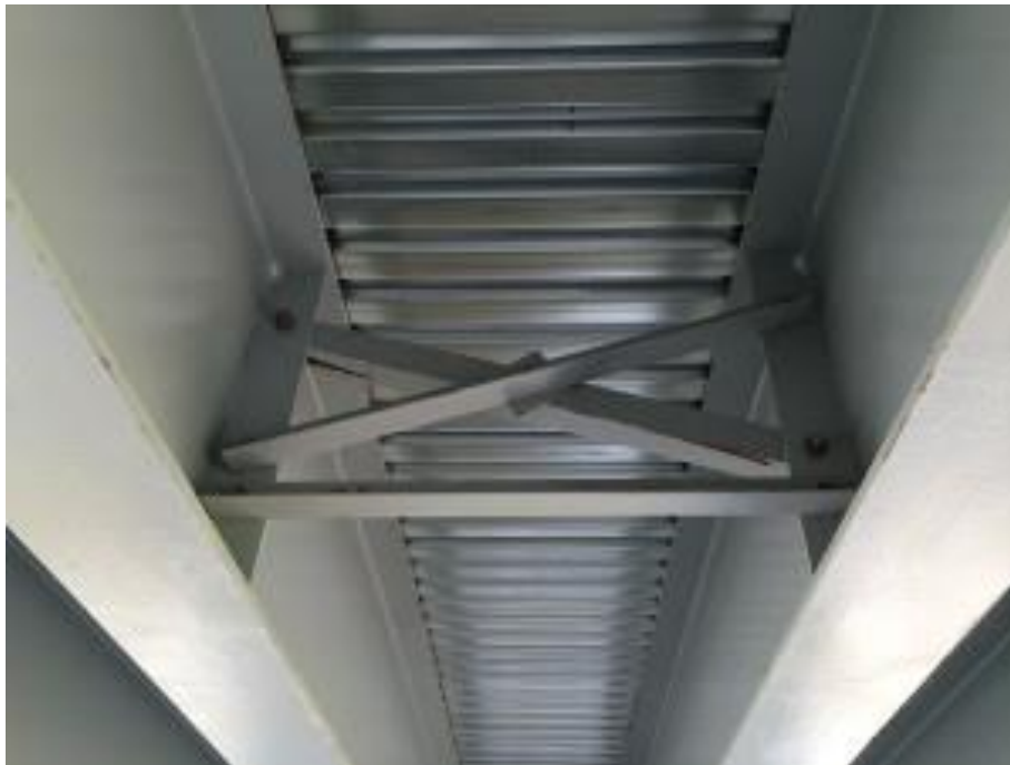
پل دره سبز پنجمین پلی است که پل جدید با استفاده از تیر های پل قبلی در شهرستان ماکسینگام جایگزین شد.
