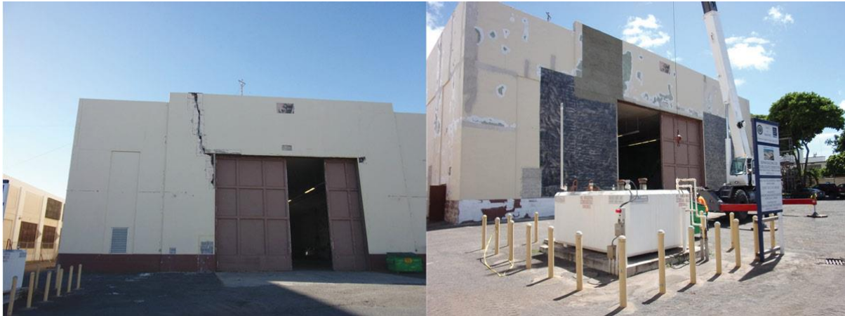
شکل ۵. تعمیر گسترده با نوارهای FRP
