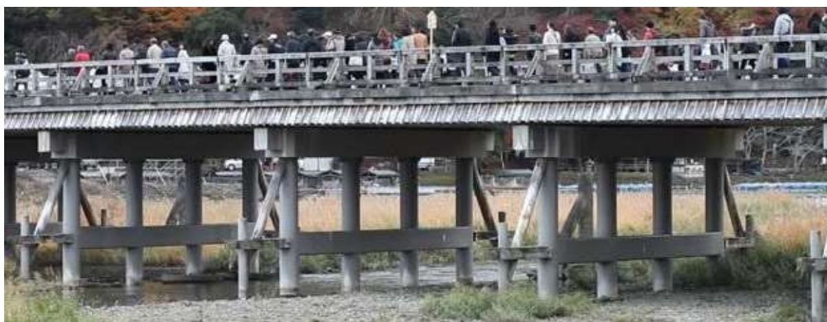
شکل ۳. پل توگوسو-کیو در ژاپن
