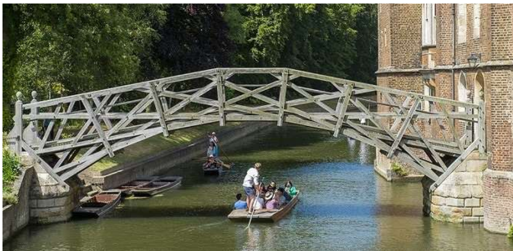
شکل ۲. پل مَتَمَتیکال، کمبریج
