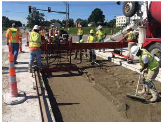
شکل ۱. لایه بستر شماتیک و اجرای لایه بستر سیمانی
