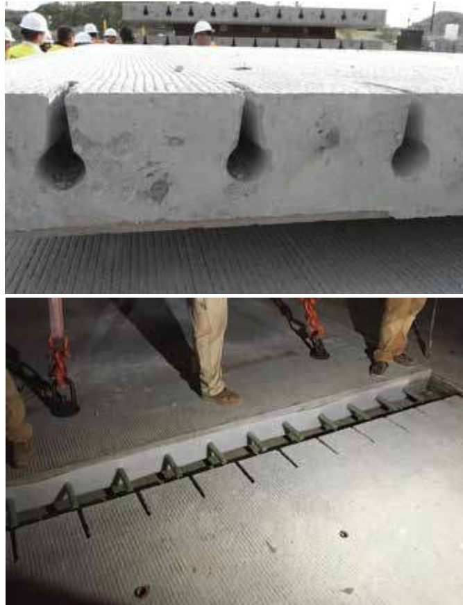
شکل ۶. شیار سطحی اشکی شکل کالیفرنیا: در بالا شکل شیار و در پایین نصب پانل نشان داده شده است
