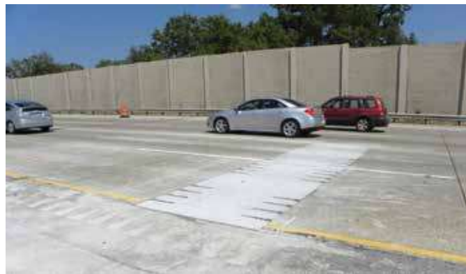
شکل ۴. تعمیر انجام‌شده با استفاده از سیستم شیارهای سطحی
