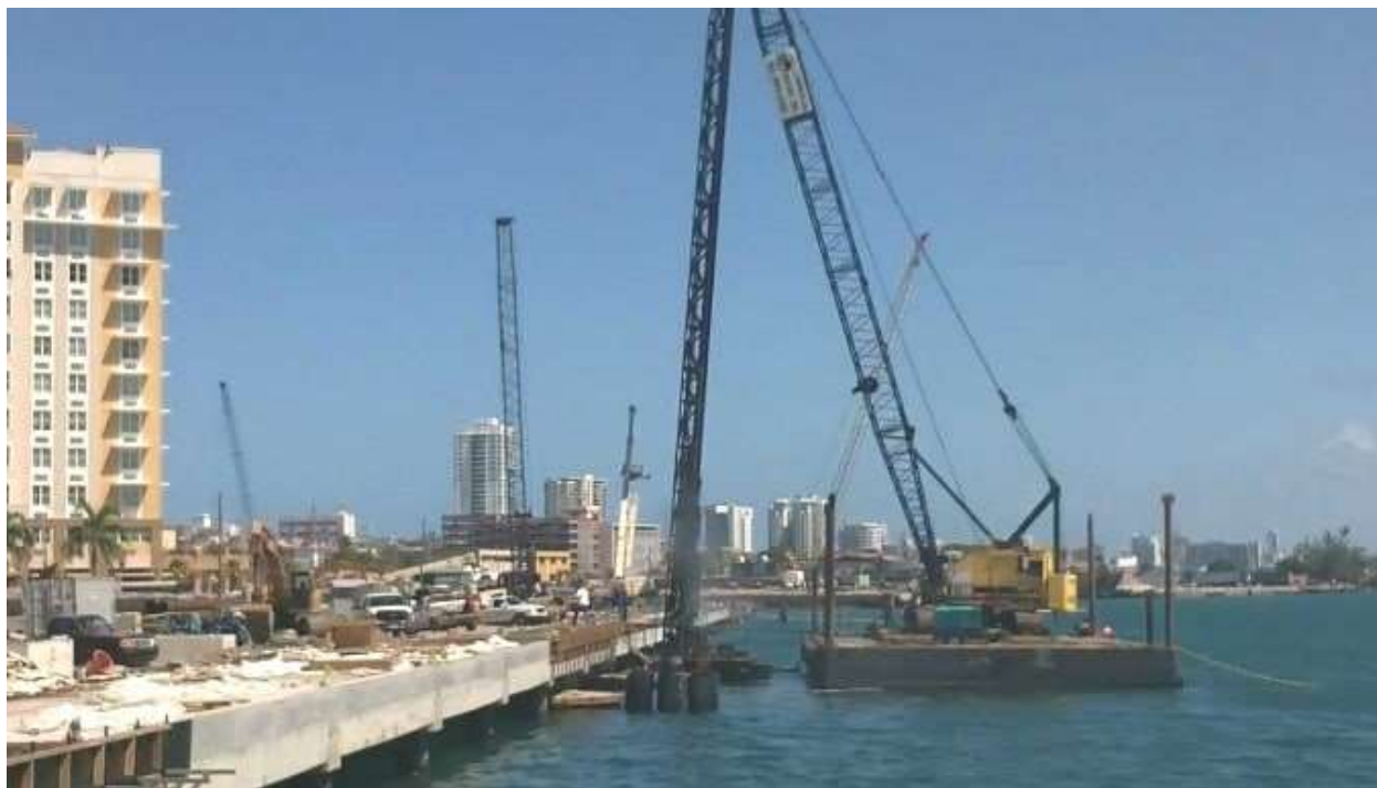
شکل ۱: شمع کوبی در آب
