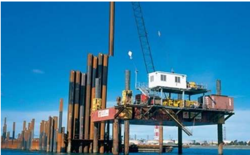
شکل ۶: شمع‌ها و قایق با جک بالا برنده
