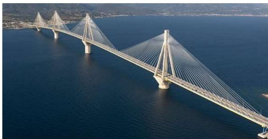
شکل ۱۲: پل کابلی ریوانتی ریو در یونان
