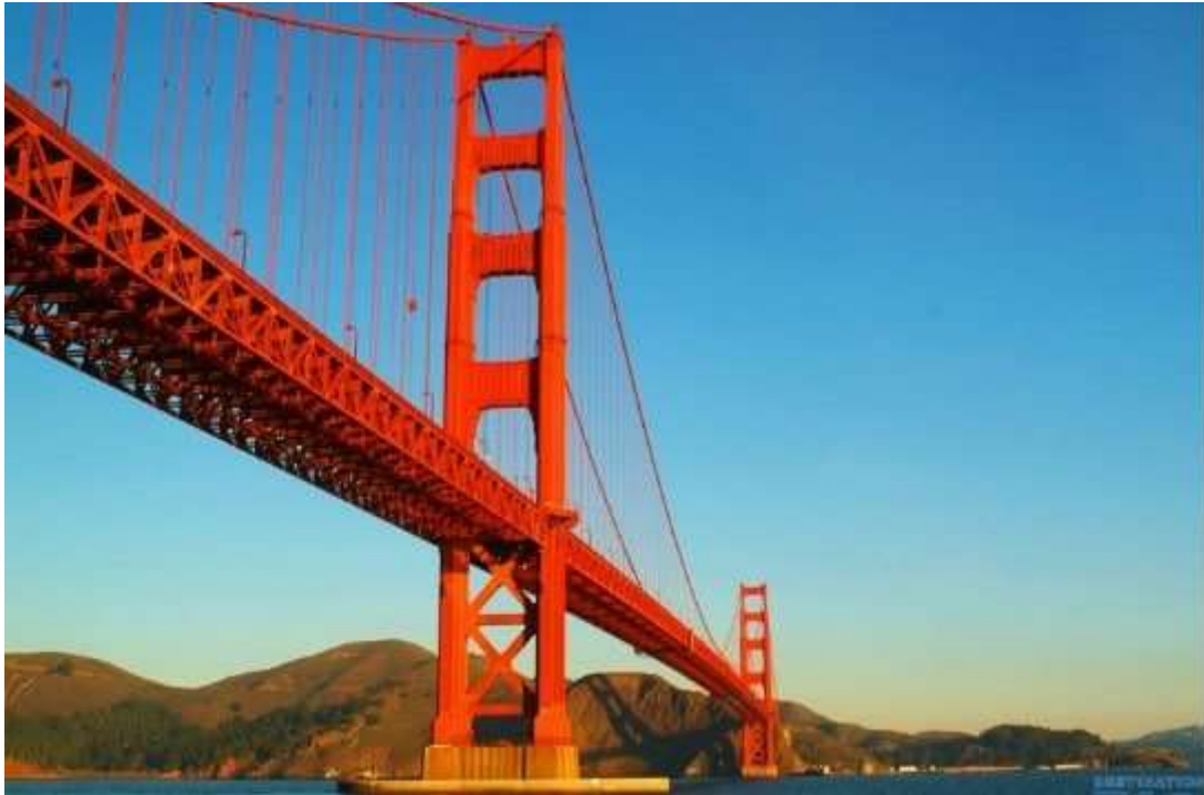
شکل ۹: شاه‌تیرهای سخت‌کننده پل گلدن گیت، تقریباً ۵۰ درصد از مهاربندهای جانبی بالا و اتصالات نیاز به مقاوم‌سازی دارند.
