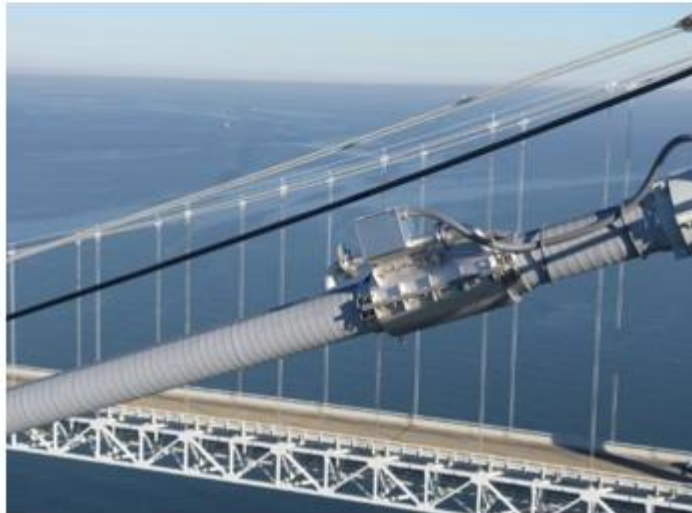
شکل-۵: رطوبت زدایی کابل‌های اصلی برای پایین نگهداشتن سطح رطوبت نسبی و جلوگیری از خوردگی کابل اصلی پل
