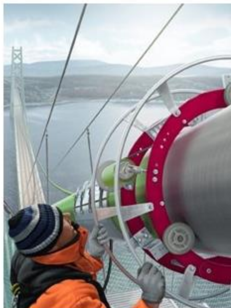
شکل ۳: روکش الاستومری کابل اصلی پل معلق
