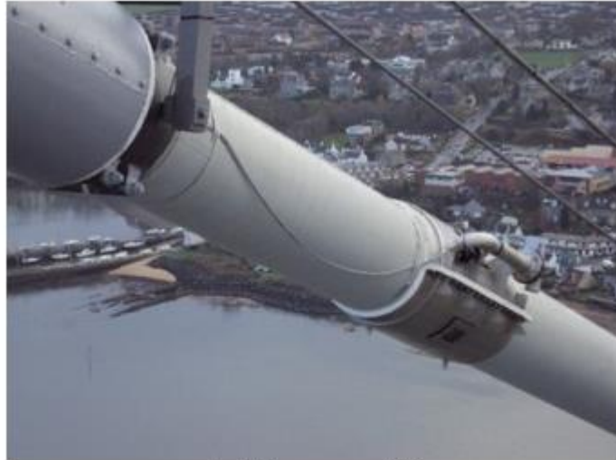
شکل-۴: دریاچه خروجی کابل اصلی
