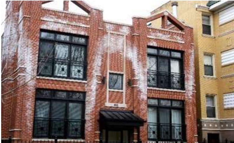
شکل ۱: شوره بر روی آجر
