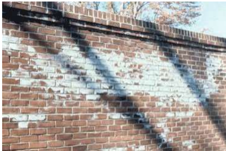
شکل ۲: شوره بر روی آجر
