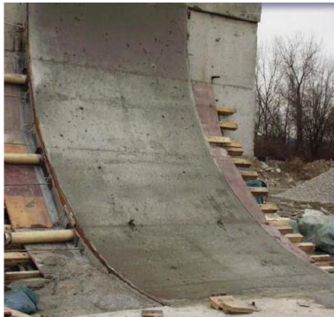
شکل ۳. فرآیند ماکت‌سازی امکان‌نصب، قالب‌بندی، طرح اختلاط و ساخت موفقیت‌آمیز را بررسی می‌کند. پیمانکار بتن شرکت
