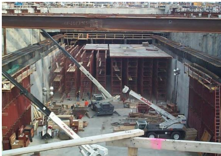
عملیات ساخت سازه تونل جعبه‌ای جک شده
