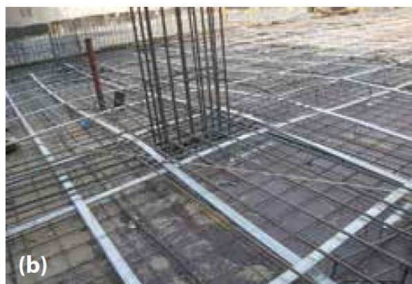
شکل ۲. ساخت دال دوطرفه با تاندون‌های پس کشیده بدون قید و مقید. (a) ساخت دال با تاندون‌های بدون قید. هیچ کدام ACI و EC2 نیاز به کنترل مقاومت در آغاز ترک خوردگی (ح ۹۹۸) ندارند. (b) ساخت دال با تاندون‌های مقید، ACI نیاز به کنترل مقاومت در شروع ترک خوردگی داشته و EC2 نیاز به این کنترل ندارد (P999).
