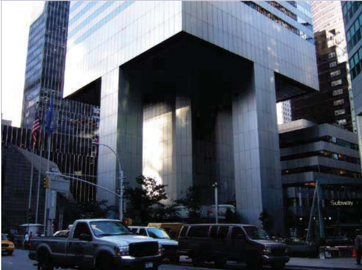
ستون‌های ویژه برج سیتی گروپ (باطراحی سازه توسط ویلیام لموزر) واقع در منهتن نیویورک که به جای در گوشه قرار گرفتن در وسط اضلاع جای گرفته است. ساختمانی که به عنوان نمونه عملی اخلاق مهندسی مطرح است.
