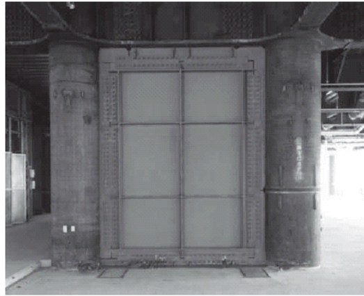
شکل ۲- دیوار برشی فولادی با سخت کننده افقی و قائم (سمت راست)، دیوار برشی فولادی با سخت کننده افقی (سمت چپ) در ژاپن
