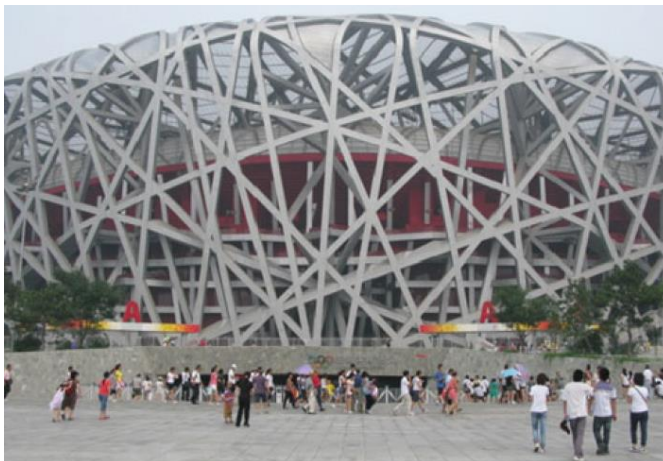
شکل ۱-۱ «خانه پرند» برای بازی‌های المپیک ۲۰۰۸، از فولاد پر مقاومت کم آلیاژ (HSLA) ساخته شده است.
