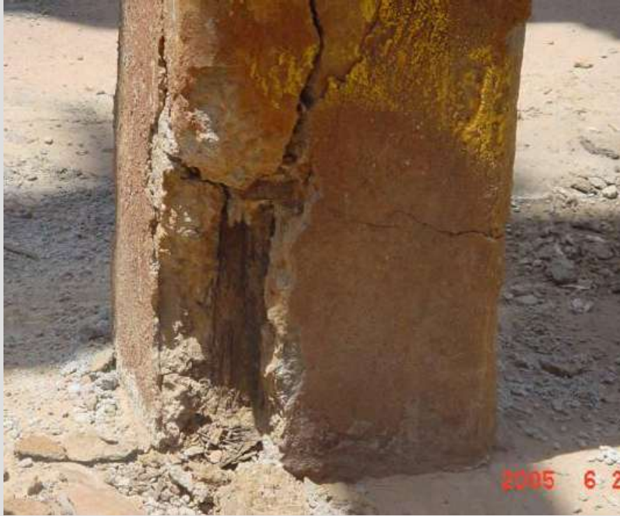
خوردگی شدید پایه پل
