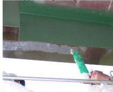
(d) Epoxy application on beam
