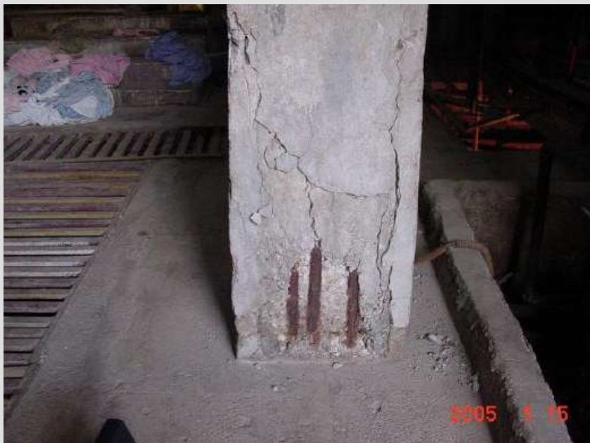
نمونه ای از حمله کربناتی و خوردگی آرماتورها
