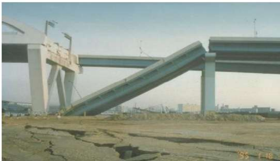
افتادگی یکی از عرش ههای پل
