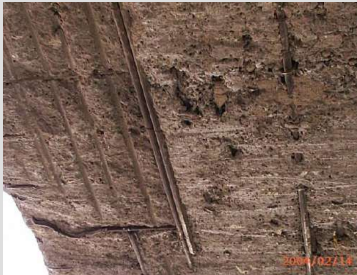
تخریب تابلیه پل
