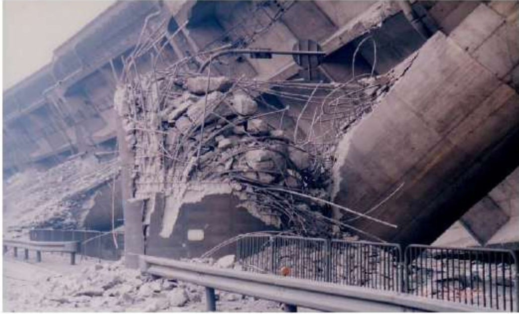
شکست برشی در پل بزرگراه
