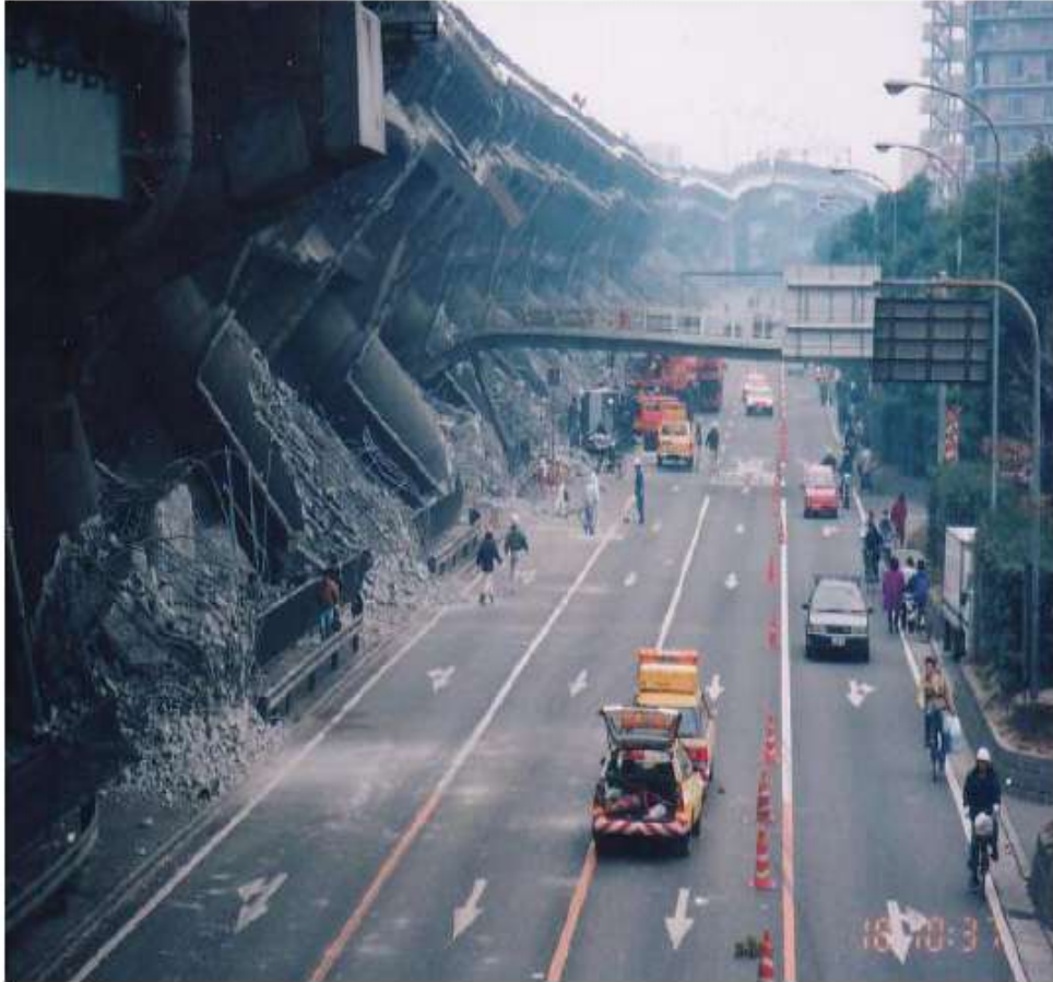
فروریزش تمامی ۱۷ قاب از پل
