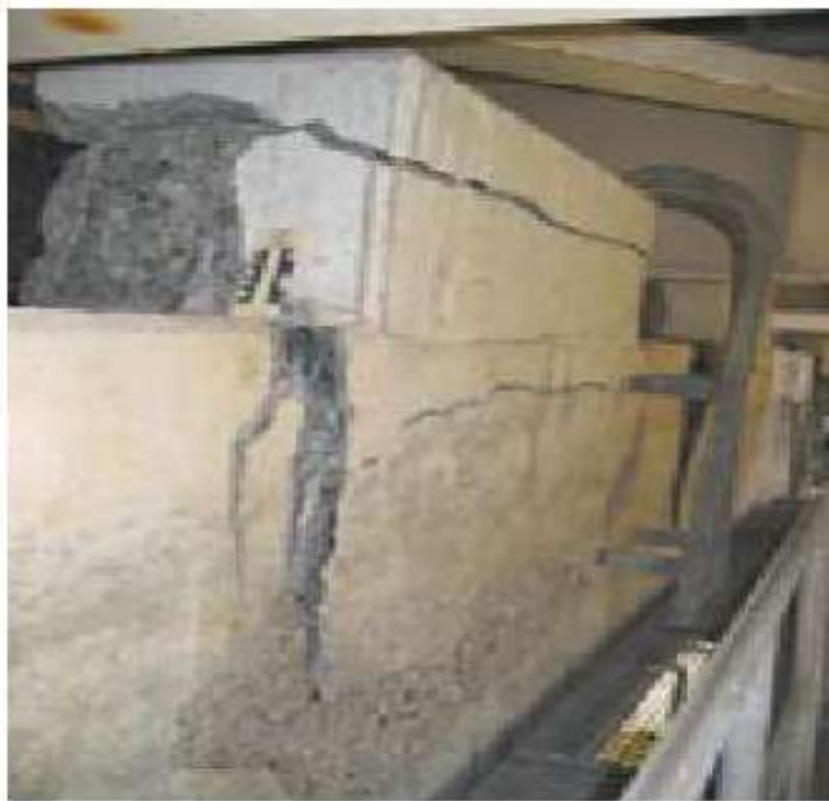
آسیب وارده به کلیدهای برشی در پل
