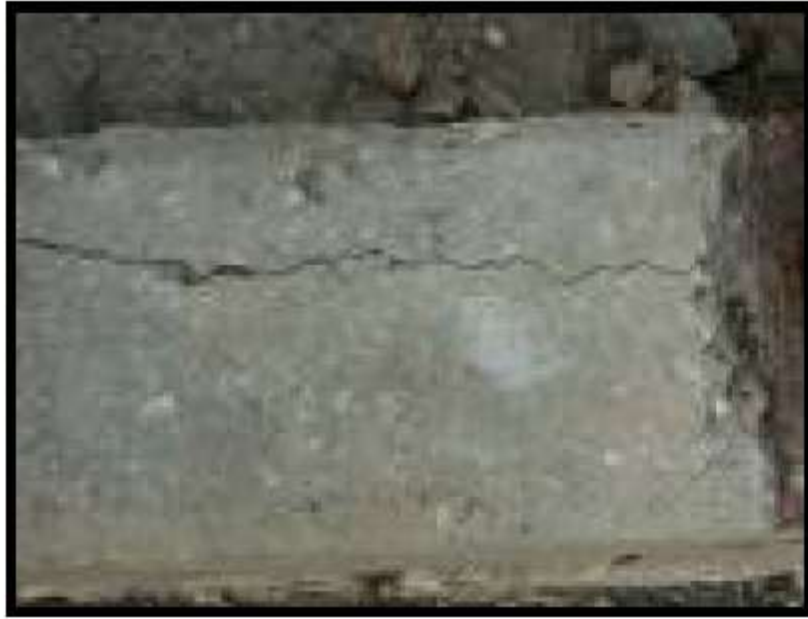
ترک خوردگی آرماتور
