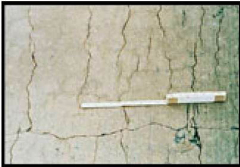
ترک ناشی از مصالح قلیایی
