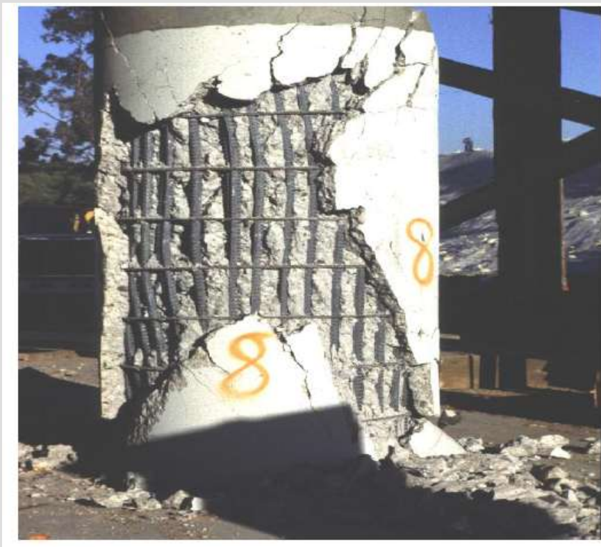
خرد شدن پوشش بتنی پایه پل تقاطع به علت ضعف خاموتها و عدم توانایی در ایجاد محصورشدگی بتن
