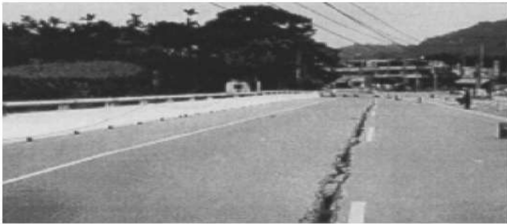
آسیب وارده به صورت ایجاد یک ترک طولی میان قسمتهای قدیمی و جدید پل
