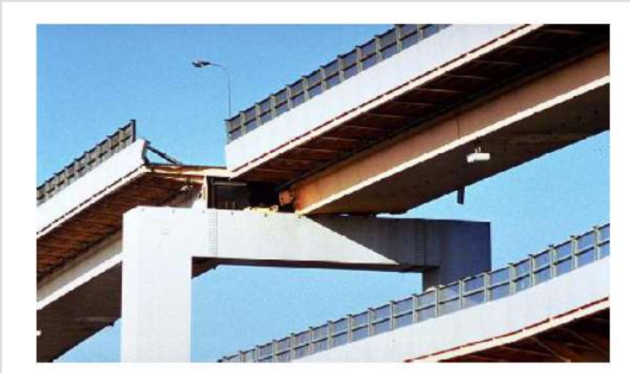
آسیب وارده به نشیمنگاه منجر به حرکت قابل ملاحظه عرشه در راستای عرضی
