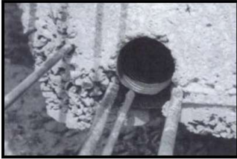
ترک Honeycomb ناشی از کمبود سیمان
