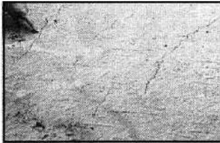
ترک ناشی از Shrinkage پلاستیک
