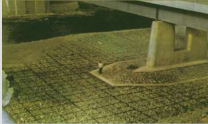
کف بند توریسنگی در اطراف پایه پل
