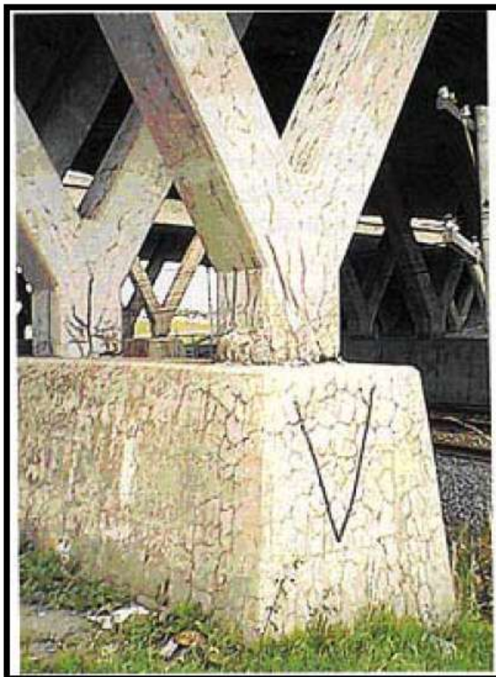
ترک Honeycomb ناشی از کمبود سیمان
