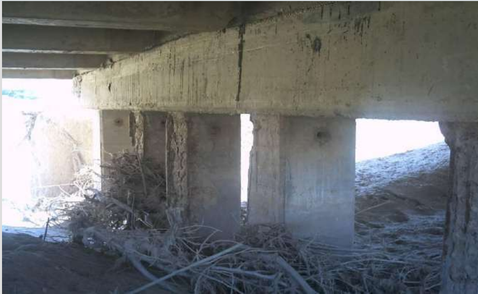
اثرات تخریبی سیلاب بر پل
