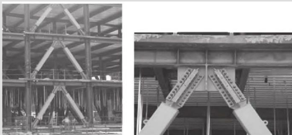
الف) BRBF با اتصالات پیچی
