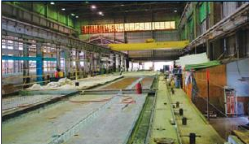
کارگاه ساخت پنل
