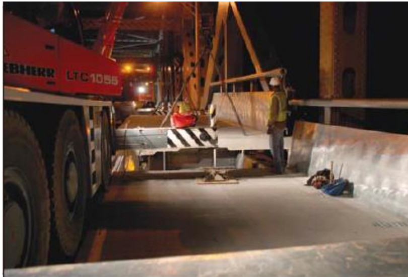
نصب پنل عرشه پیش ساخته بیرونی
