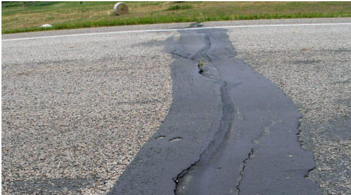
شکل ۱: شرایط آب و هوایی سرد می‌تواند سبب ایجاد و گسترش ترک‌های دائم در روسازی بتنی و آسفالتی شده و سبب افزایش عملیات نگهداری و هزینه‌ها شود
